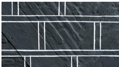
Udsnit af det overmalede bindingsværk Det ligner sten. Flot illusion! Bindingsværket anes bag opstregningerne
